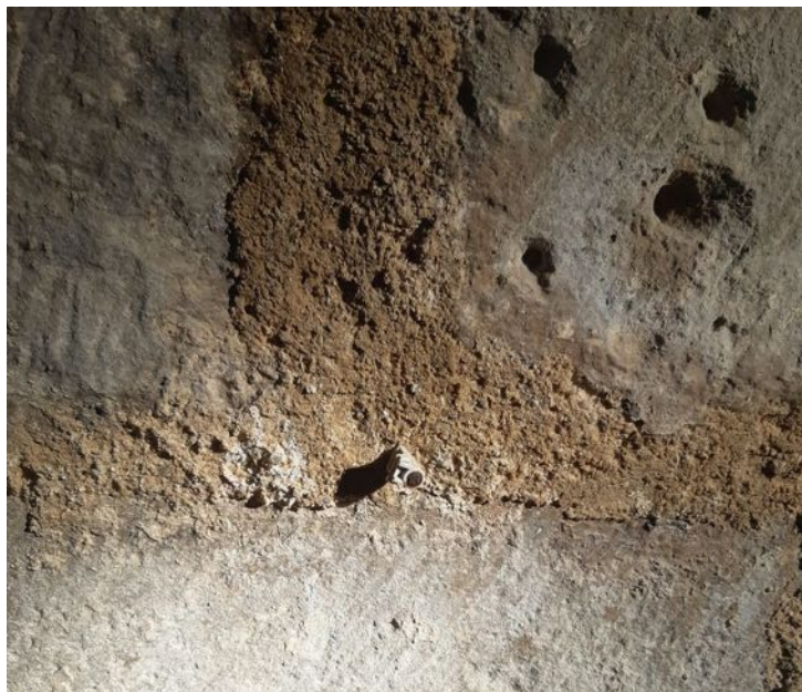
Mur de l'église Saint-Savinien © Photo : Marion Robin
